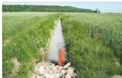
Avaloir aménagé pour la faune (7)
